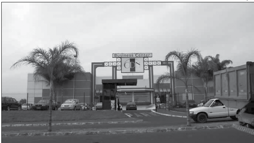
Escritório regional Camda no Business Center em Uberlândia/MG
